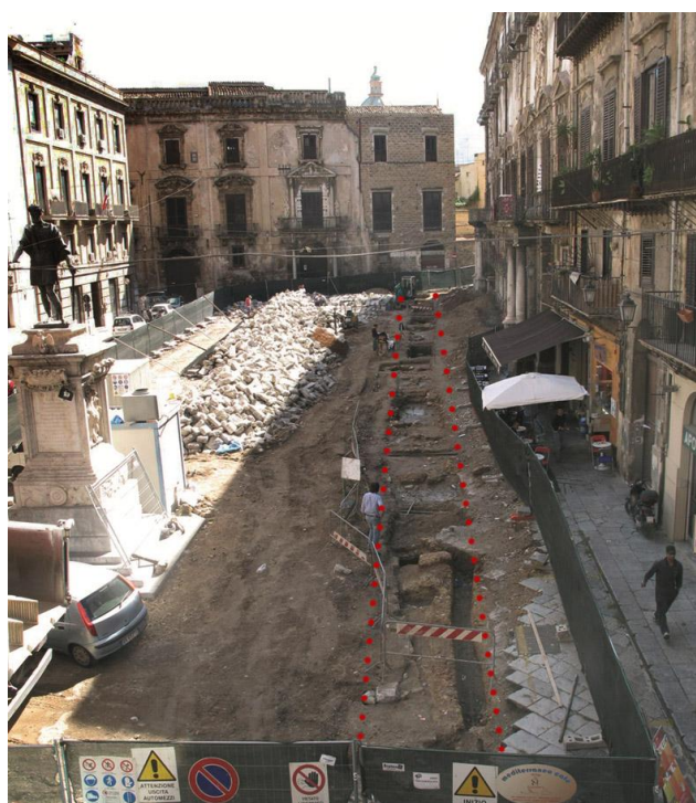
Fig. 2 La trincea di scavo vista da Nord
